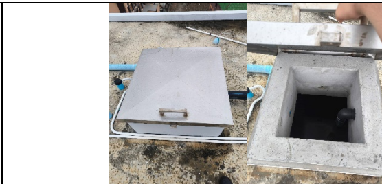
รูปที่ ๗.6 ถังสำรองน้ำใช้บริเวณคาดฟ้า
