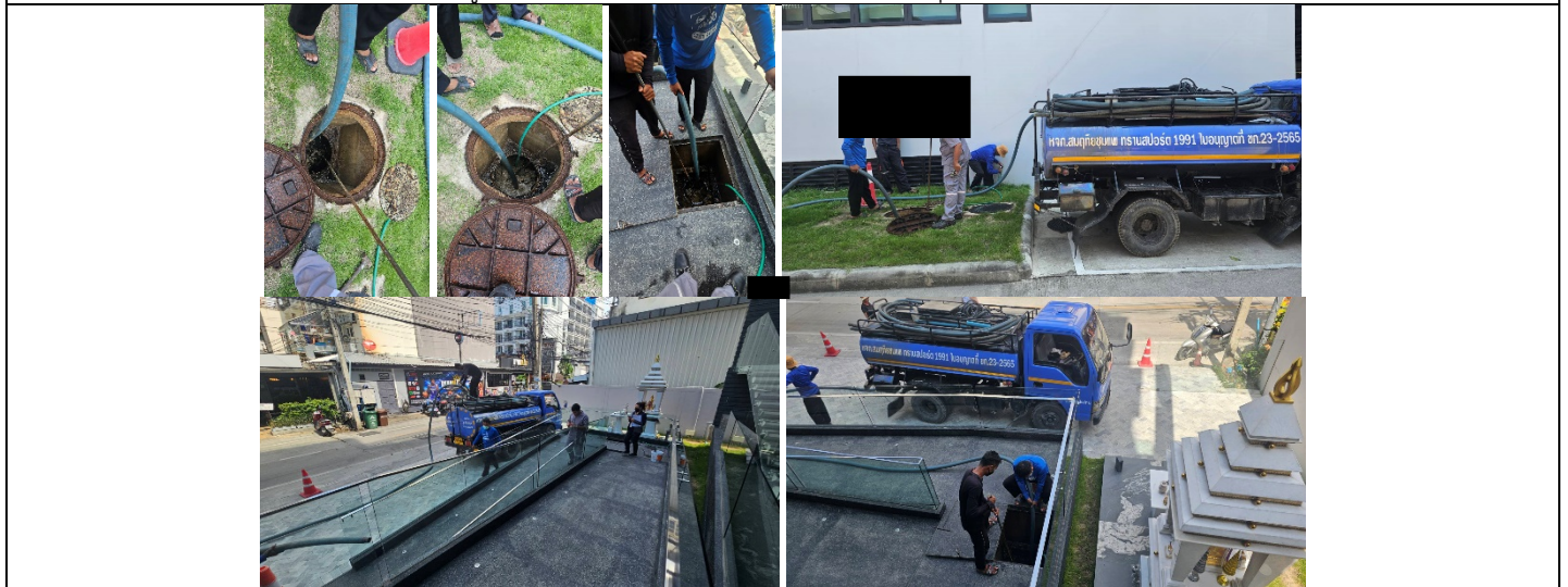
รูปที่ ผ7.57 การสูบน้ำส่วนเกินออกจากถังบำบัดน้ำเสีย
